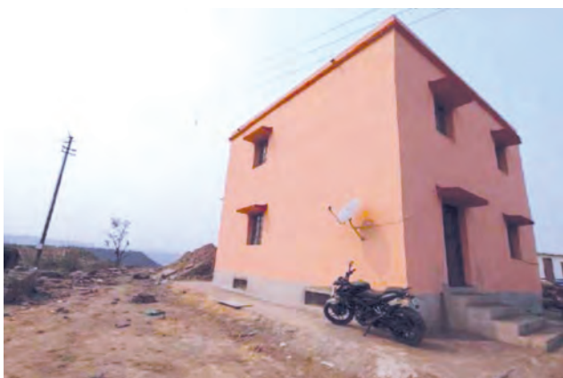
चित्र 1 “बैक फील्ड खुली कोयला खनन पर संरचना निर्माण : व्यावहारिक प्रणाली सुझाने के लिए प्रयास” शीर्षक वाली विज्ञान एवं प्रौद्योगिकी परियोजनाकेलिए जगन्नाथ एरिया, एमसीएल में निर्मित प्रोटोटाइप भवन।
